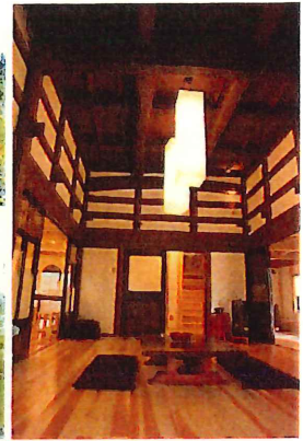
古民家の設え(枠の内づくり)
