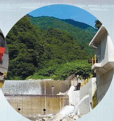
相ノ又谷水力発電所 朝日町 961.0 kW
