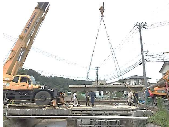
《撤去状況(H28.10月)》
