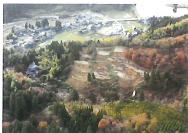
平成14年11月 氷見市谷屋地区地すべり
