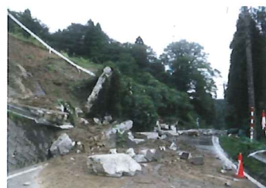
平成30年8月 氷見市棚懸地内の土砂災害
