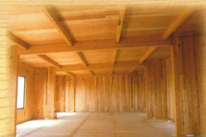
CLTを用いた倉庫 (栃木県)
