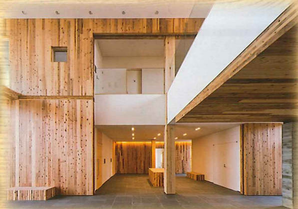
CLTを用いた事務所 (高知県)
