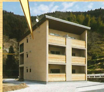
パネルを組み合わせで建築
