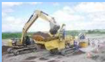
新規制定工種「安定処理工(自走式土質改良工)」
