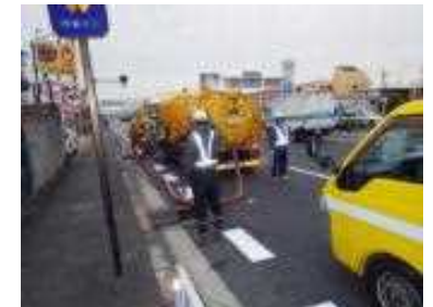
管渠清掃作業
