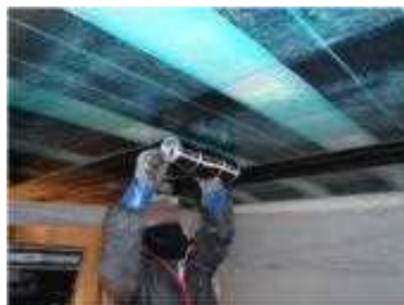
炭素繊維シート接着状況
