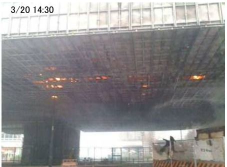
【②下り線 足場下】 撮影日:3/20
