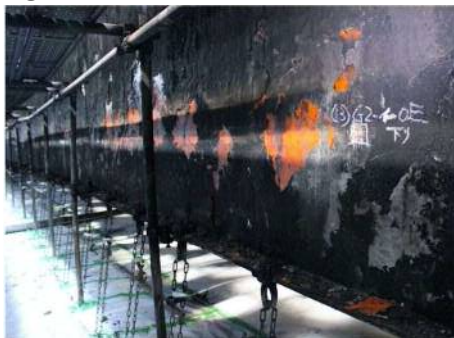
【①下り線 足場内】 撮影日:3/22
