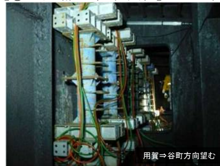
【④下り 桁内部 仮支柱】 撮影日:3/23
