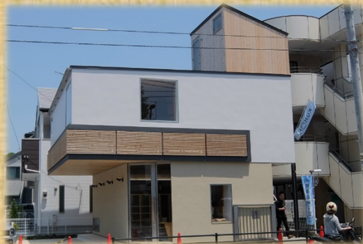
CLTを用いた店舗 (神奈川県)
